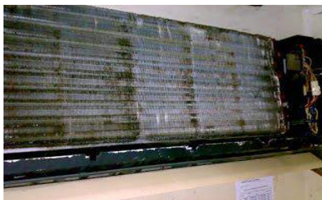
Gambar 4 Fin dengan Noda kerak
